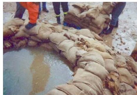
Im Abstand von etwa 0,5 Meter um die Quelle werden etwa 5 Sandsäcke parallel gelegt. Hierauf setzt man mind. 10 - 12 Sandsäcke auf. Die Innenseite wird senkrecht hochgebaut. Anschließend werden die Sandsäcke parallel zur Quelle an diesen Deich angeschlossen und dicht verlegt.
