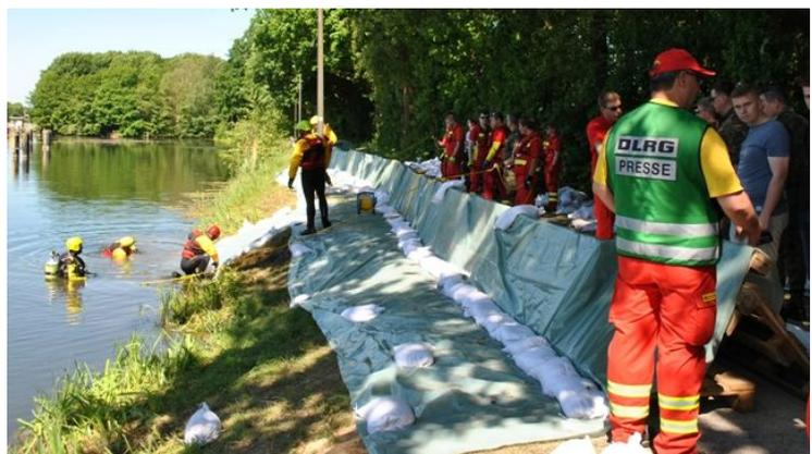
Um die Standfestigkeit der Konstruktion zu erhöhen empfiehlt es sich auf der Wasserabgewand- ten Seite das Gestell mit Erd- oder Asphaltnägel zu befestigen. Bei einer Deichaufkantung sollte die Standfestigkeit durch die Ablage von mind. fünf Sandsäcken an der wasserabgewandten Sei- te erhöht werden.
